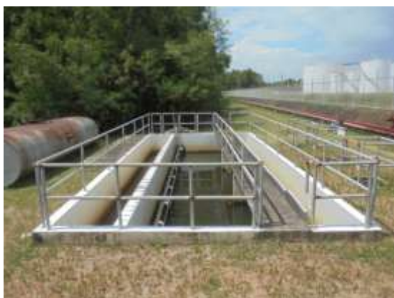
รูปที่ 3-1 บ่อ API หลังคลังน้ำมันเชลล์ สงขลา
