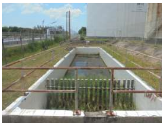
รูปที่ 3-2 บ่อ CPI หลังคลังน้ำมันเชลล์ สงขลา
